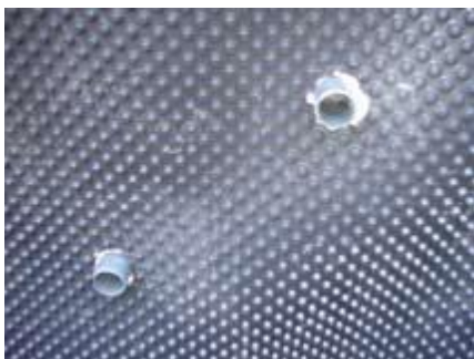
Montera platonmattan innan rören ansluts till inbyggnadsdelarna.
